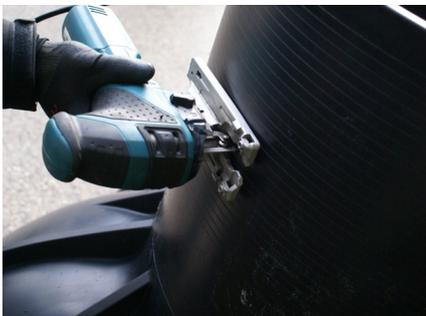
Der Schachthals (cut) kann mit geeignetem Werkzeug vor Ort gekürzt werden.
