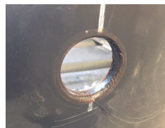
2. Schachtboden aufbohren
