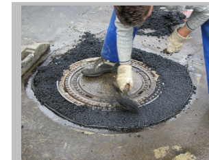
11. Aufbringen des Kalt- oder Heißbitumens
