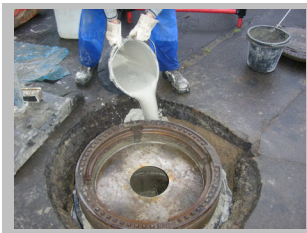
9. Verfüllen des aufgestemten Fugenspalts mit Gießmörtel
