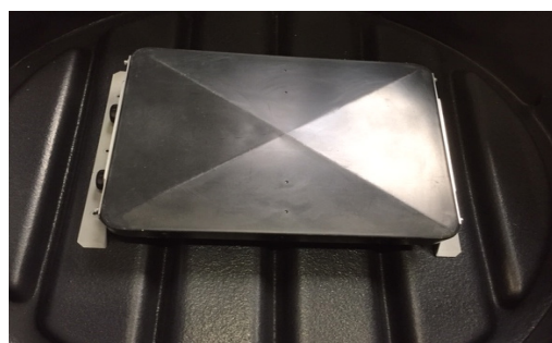
4. teleskopierbare Zählerbrücke im Schachtboden platzieren
