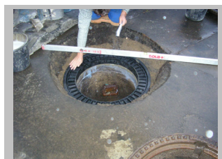
4. Ausrichten des Ringes
