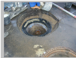
5. Aufbringen des Mörtels auf den Ausgleichsring
