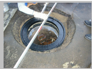
6. Aufsetzen und Ausrichten des 2. Ausgleichsringes
