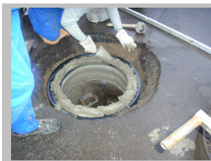
7. Vorbereitung des Mörtelbetts für den BEGU-Rahmen
