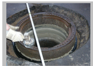
8. Aufsetzen und Ausrichten des BEGU-Rahmens
