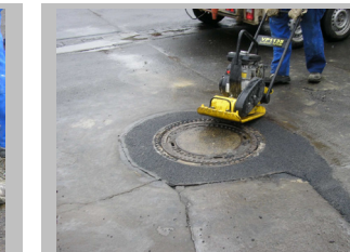
12. Verdichten der Verschleißschicht
