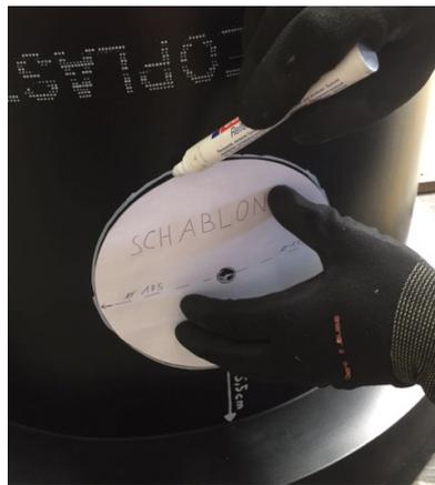
Bohrschablone DN160 zentrisch über beide Bohrungsmarkierungen platzieren und Umfang markieren
