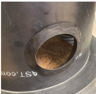
Zulaufdichtungen DN160 in beide Bohrungen montieren
