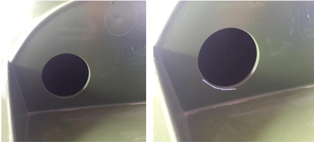
Die Bohrschablone wird am bestehenden Tanküberlauf so platziert, dass der untere linke Teil der Bohrung, gleich liegt wie der untere linke Teil der Schablone. (siehe mittleres Bild unten)
