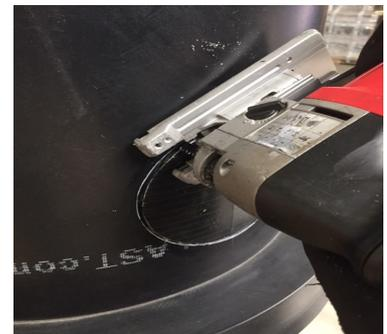
Beide Markierung mit geeignetem Werkzeug (Stichsäge, Lochsäge, etc.) ausschneiden
