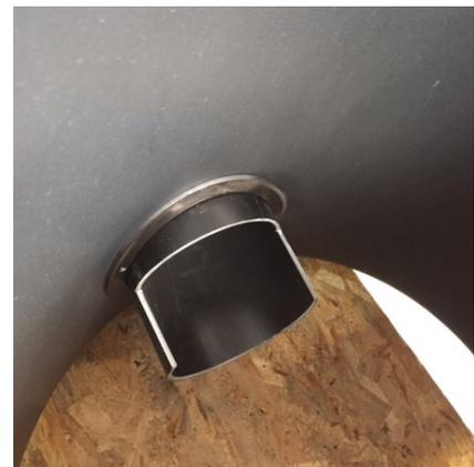
Anschlussrohre DN160 von innen durch die Zulaufdichtung stecken
