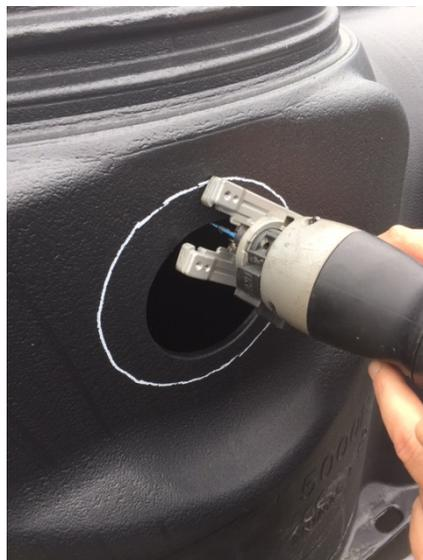
Mittels geeignetem Werkzeug (Stichsäge, Lochsäge, etc.) Tanküberlauf DN160 aufschneiden.
