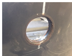
2. Schachtboden aufbohren
