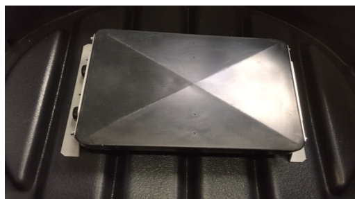
4. teleskopierbare Zählerbrücke im Schachtboden platzieren
