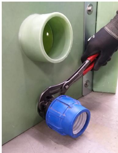
Schritt 17: ASKV-Verschraubung mit der Wasserpumpenzange festziehen.
