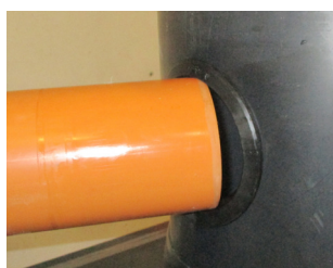
5. KG-Rohr in Zulaufdichtung stecken
