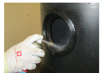
4. Gleitmittel auftragen
